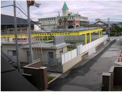
・プールに設置している太陽光発電パネル
