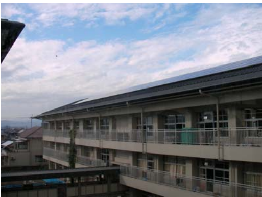
・校舎屋上設置の太陽光発電パネル
