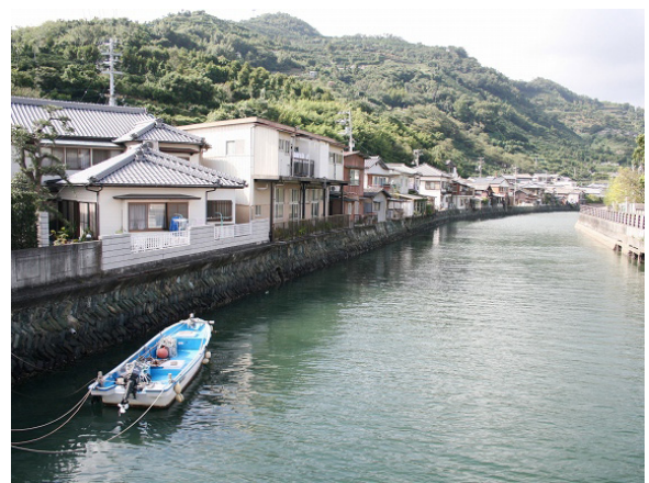
宮内川右岸の青石積み護岸
