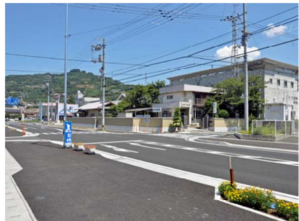
拡幅整備が進む県道八幡浜保内線
