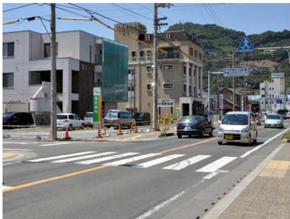
拡幅整備が進む国道197号
