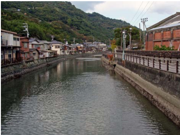
レンガ倉庫と対岸の青石護岸
