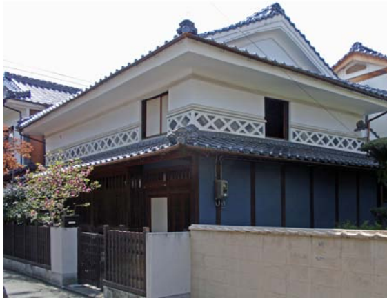
なまこ壁が美しい増築された住宅(向灘)
