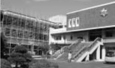
保内中学校大規模改造工事
