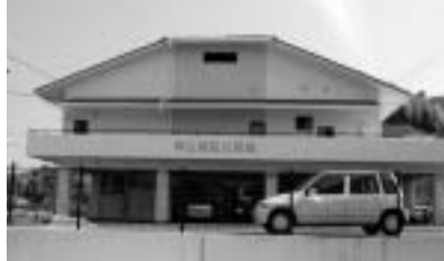
神山地区公民館新築工事
