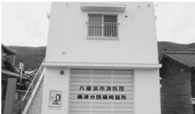
磯津分団消防倉庫新築工事
