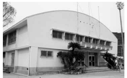
地震補強が行われる3つの小中学校のうちの1つ宮内小学校（体育館）
