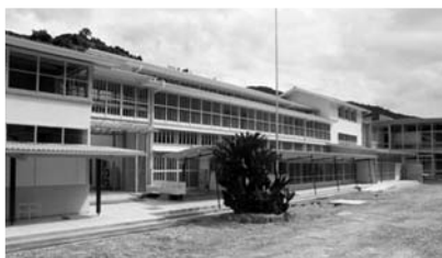
日土小学校改修改築事業
