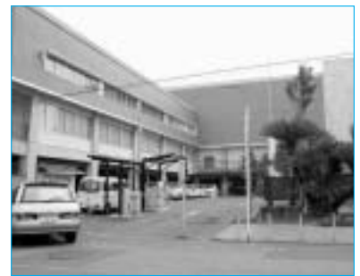
市民会館ホワイエ改修工事
