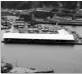
仮設魚市場建設工事
