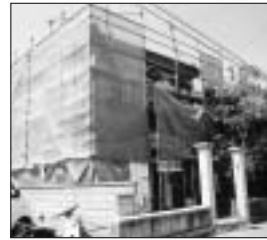
旧白石和太郎洋館改修工事
