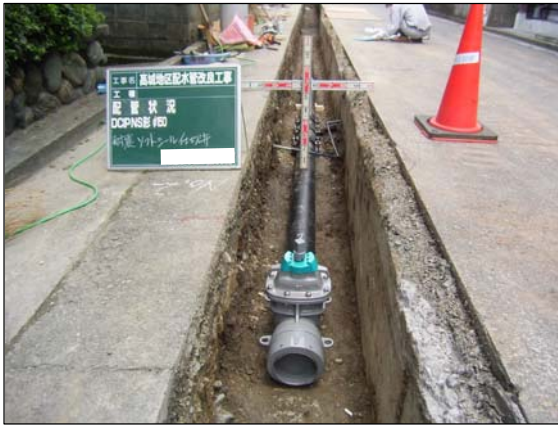
耐震管布設替状況（NS型耐震管）
