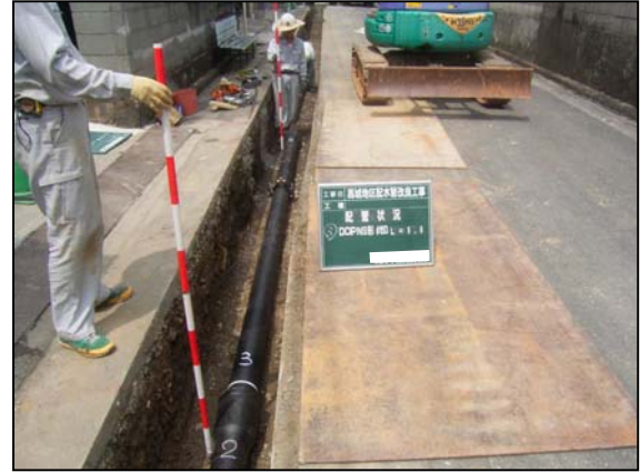
耐震管布設替状況（NS型耐震管）
