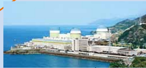
(四国電力HPより)
