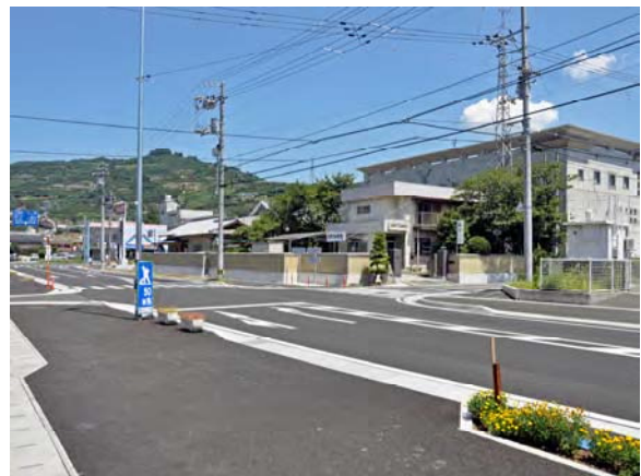
拡幅整備が進む県道八幡浜保内線
