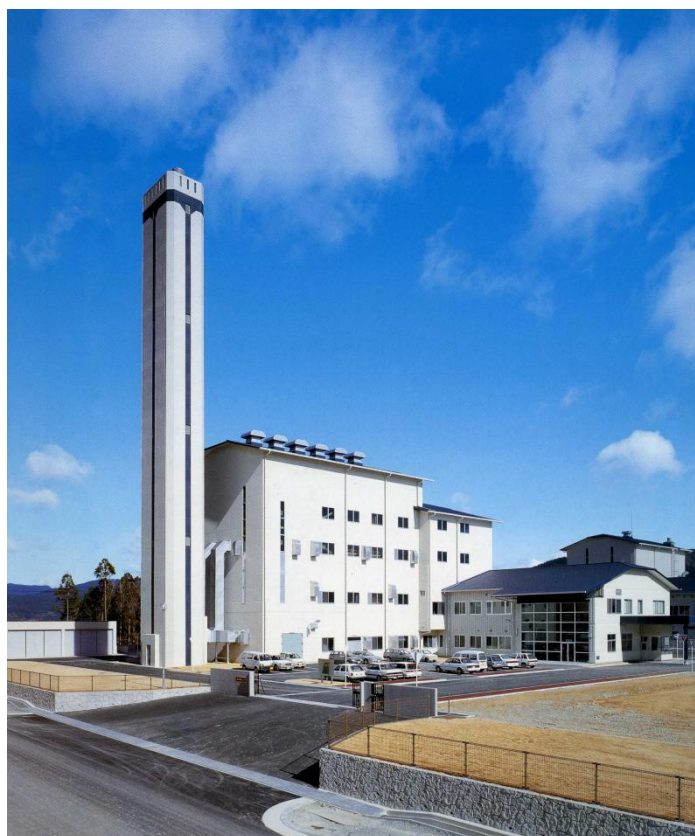
八幡浜南環境センター
