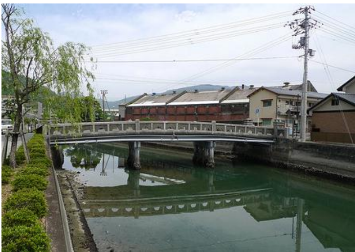
美名瀬橋と赤レンガ倉庫跡 (写真左)
