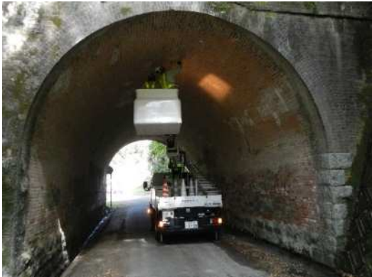
千賀居トンネル
