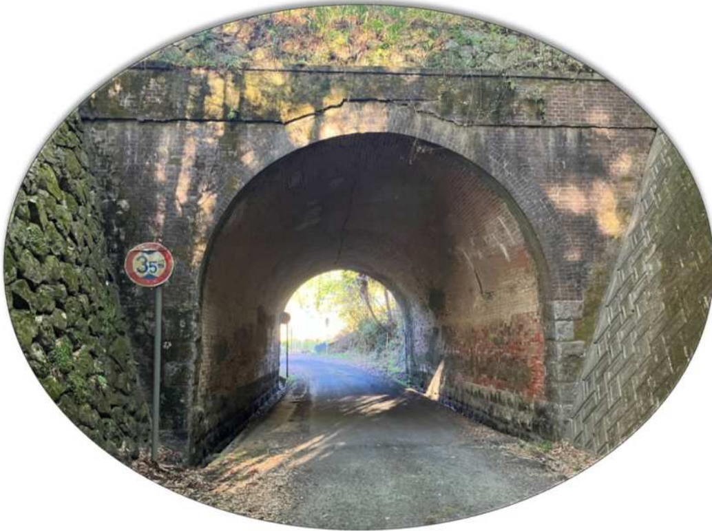
千賀居トンネル
