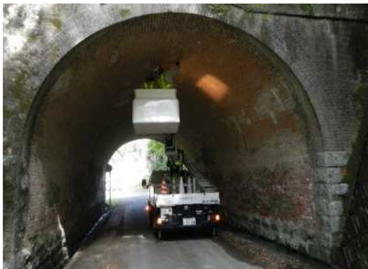
千賀居トンネル
