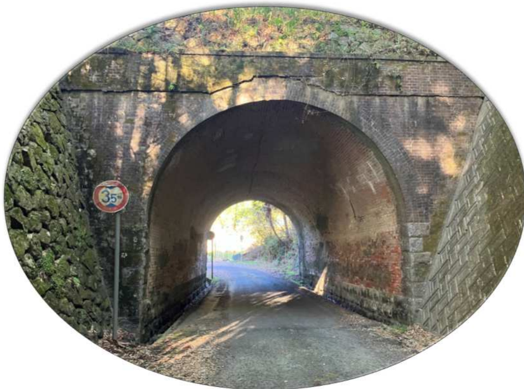
千賀居トンネル
