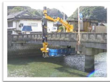
点検状況（千代田橋）
