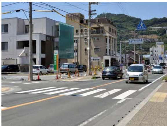
拡幅整備が進む国道197号
