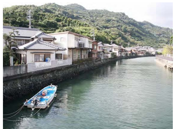
宮内川右岸の青石積み護岸
