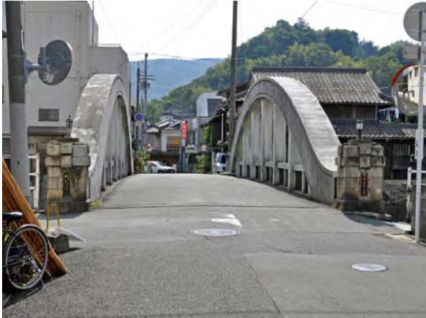
明治橋(現存日本最古のRC造下路式橋梁)
