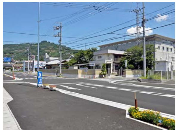
拡幅整備が進む県道八幡浜保内線
