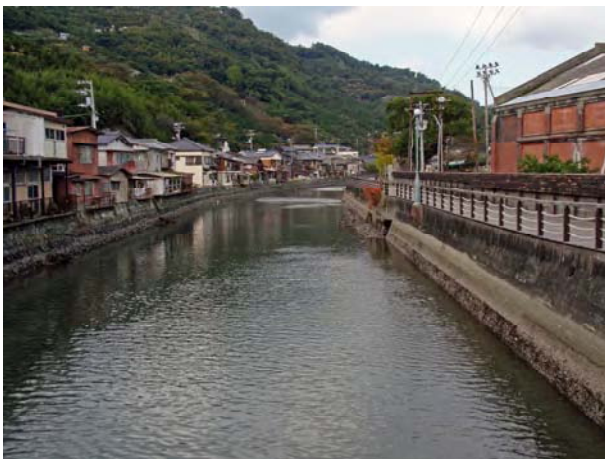
レンガ倉庫と対岸の青石護岸
