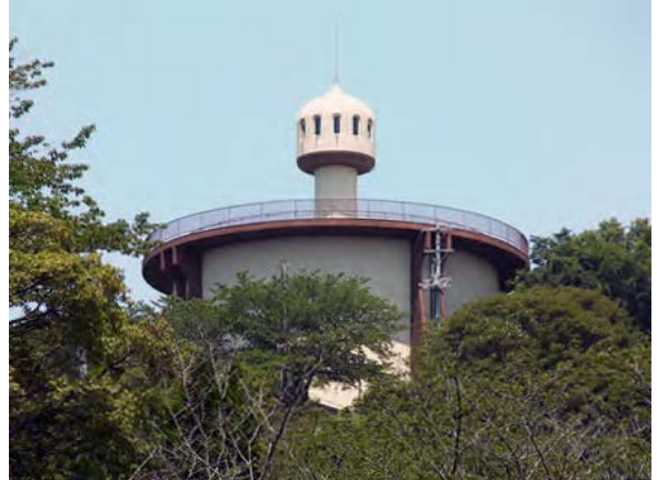
よく見えるモニュメンタルな給水塔
