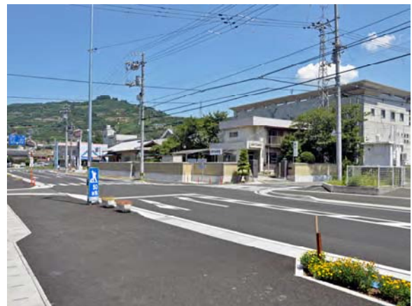
拡幅整備が進む県道八幡浜保内線
