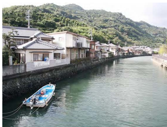
宮内川右岸の青石積み護岸
