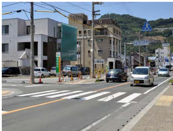
拡幅整備が進む国道197号
