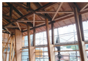
旧図書館移築工事の様子
