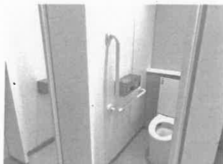
非常用トイレ(断水時使用可)
